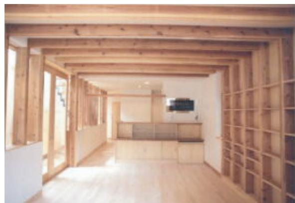
j. Podは、口の字型に組んだ木枠を等間隔に並べて、一部を鋼材で補強した強力な耐震性能のある「箱」=Pod。
