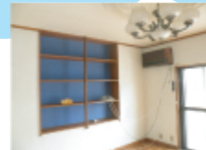
工事前:壁にご注目
