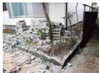
←ブロック解体
