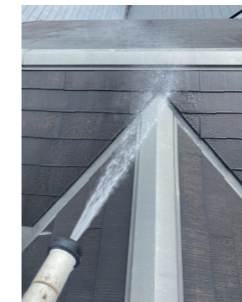
↑屋根雨漏れ検査
