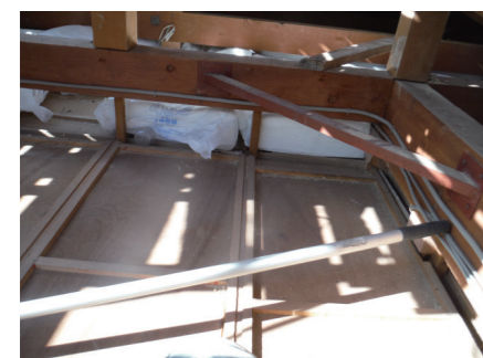
③知らず知らずのうちに数ヶ所の雨漏れもあり、木材が腐食していました。
